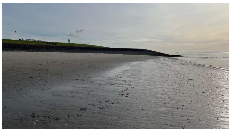
Figuur 10: Zandige ondergrond van een oever aan de Westerschelde, begrensd met een geasfalteerde dijk.
