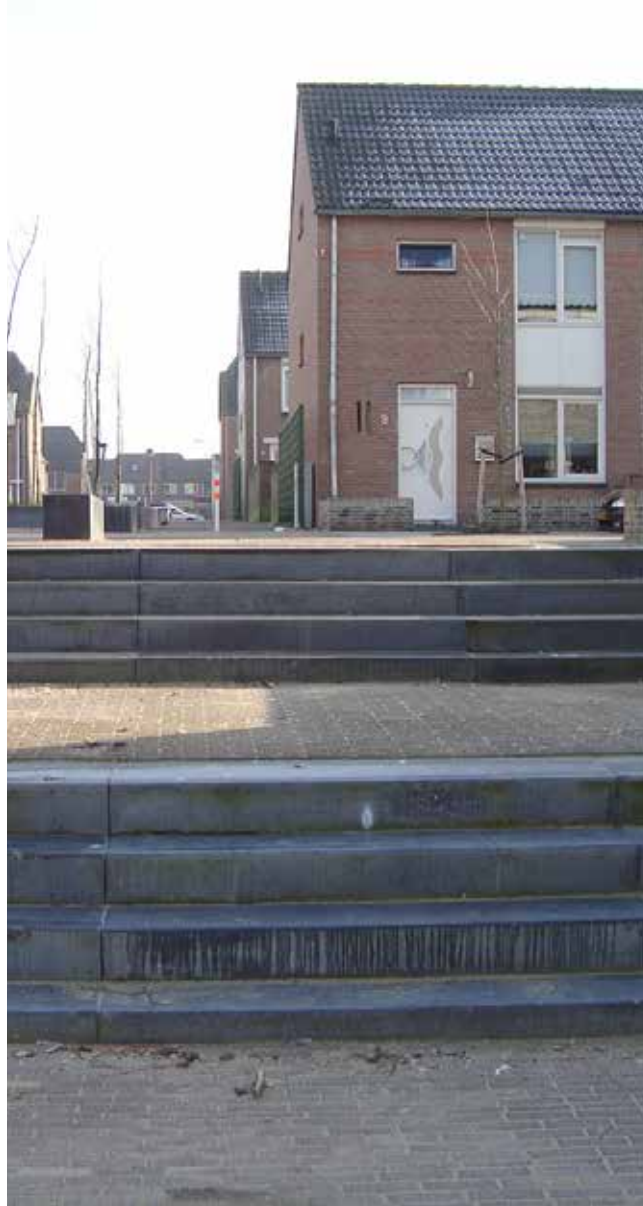
[150] Trappen moeten met de hand worden geveegd, of schoon worden geblazen.
