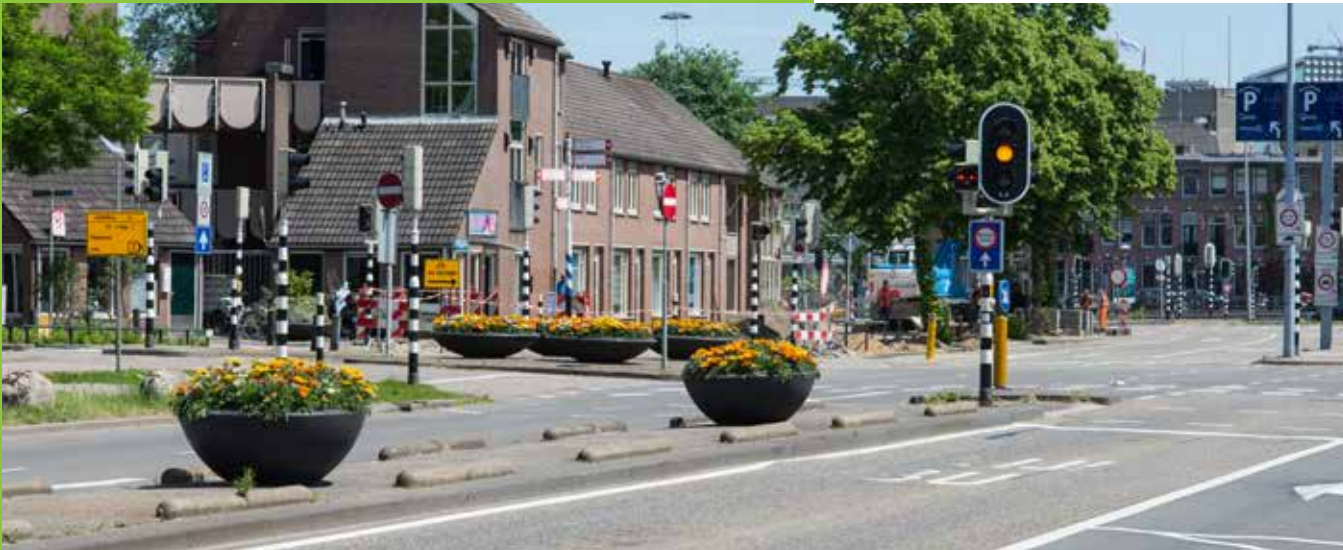
[153] Middenbermen zijn niet altijd even makkelijk veilig bereikbaar om schoon te maken. Deze inrichting zorgt er voor dat zwerfafval naar de zijkanten kan waaien. De bloembakken geven accent aan de omgeving, terwijl de ondergrond verhard blijft zodat er geen zwerfafval in het gras kan blijven hangen.
