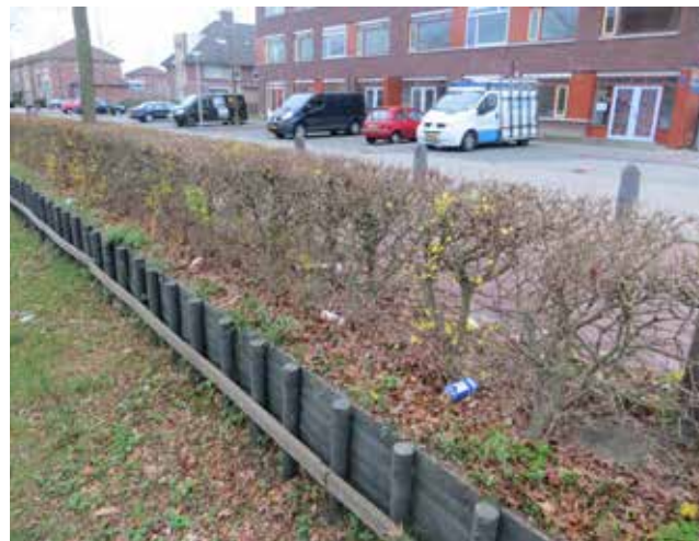
[68] Ook in dit talud komt zwerfafval terecht. Het voordeel is dat door het houten hekje het verspreidingsgebied van het afval klein blijft. Dat is een bijkomstig voordeel, want het hekje is primair bedoeld om de grond te keren.
