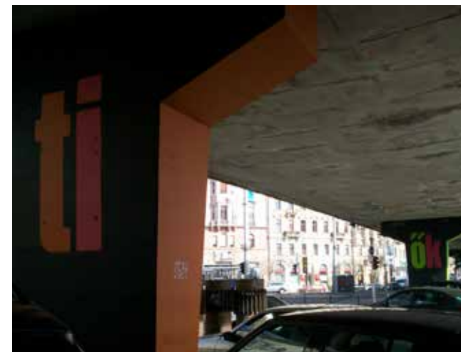
[66] Op de kolommen onder een viaduct is een boodschap aangebracht die ervoor zorgt dat de plek verbinding maakt met de omgeving.
