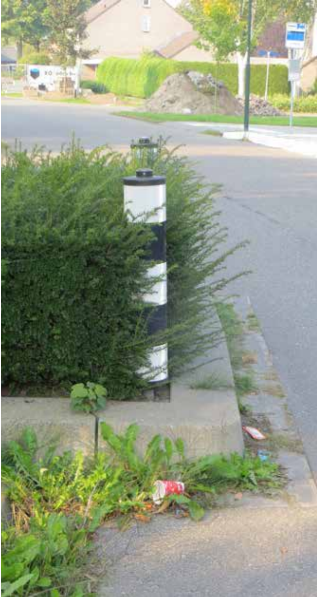
[149] Rechte hoeken zijn niet bereikbaar met de veegmachine. Het hoge onkruid houdt het zwerfafval extra vast.
